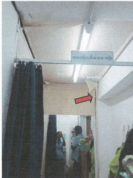
ผนังชนเสาด้านหลังอาคารฉีกกร้าวด้านขวา/มีน้ำไหลซึม
